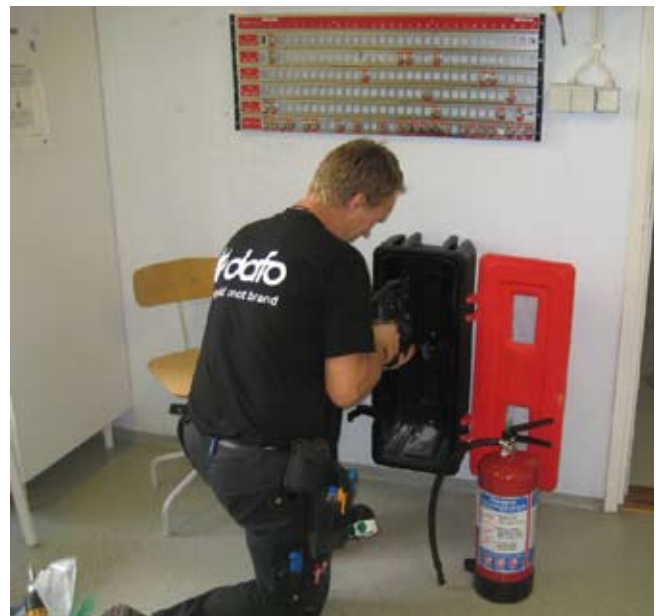
Nya pulversläckare har monterats i de flesta tvättstugorna i Brf Svartvik. Monteringsarbeten fortsätter under hösten.
