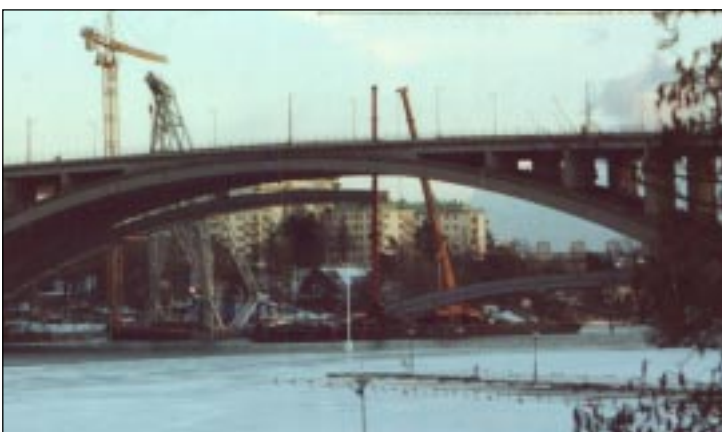
Den 16 mars kom Lodbrok med ett nytt brospann till Tranebergsbron. Här lyfts del två på plats. varje halva är 90 meter lång och väger 135 ton!
