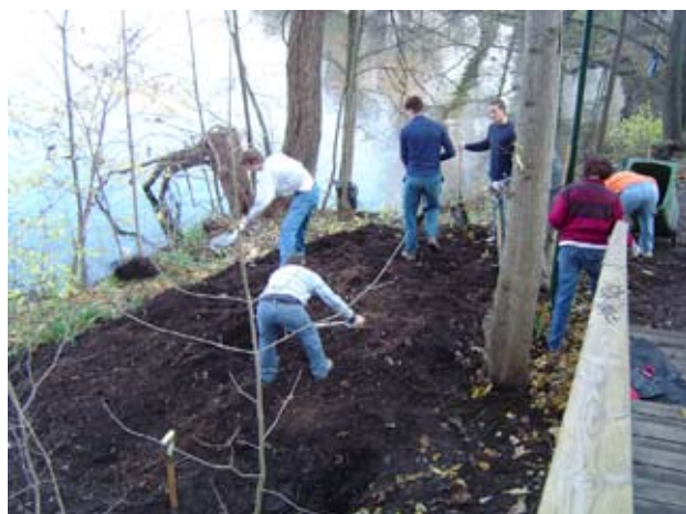
Det krävdes hårt arbete och mycket grävande.....
